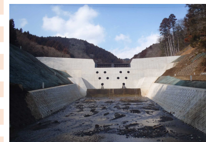
柳島砂防ダム完成写真
