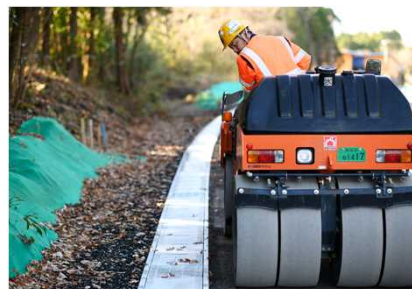
舗装技術者(現場風景)
