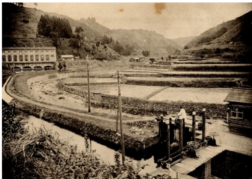
写真 4-1 明治時代完成当時の須川発電所（大正元年（1912）12月運用開始）
