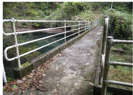
写真 4-8 現在の阿多野用水池の堰堤
