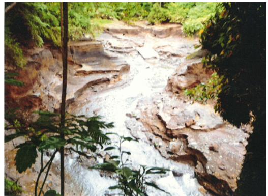
写真 4-6 池底が流失した阿多野用水池
