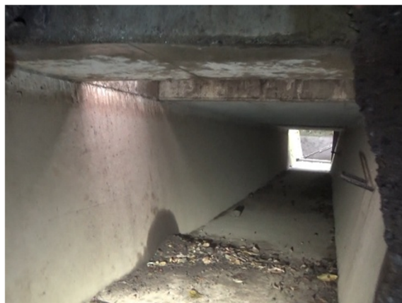
写真 3-16 管理坑とコンクリート水路
