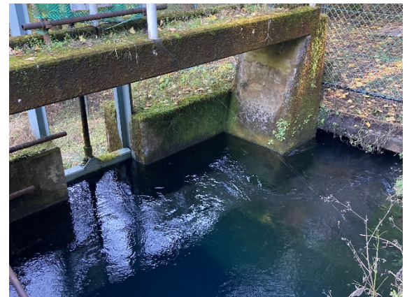
写真 3-14 集水桝と水門
