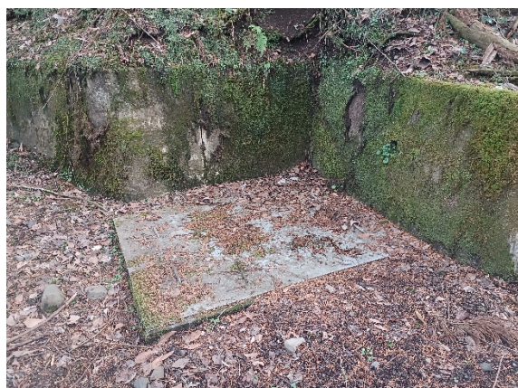
写真 3-15 水門付近の管理坑
