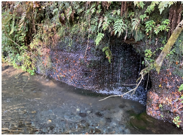
写真 3-11 阿多野用水池の取水口
