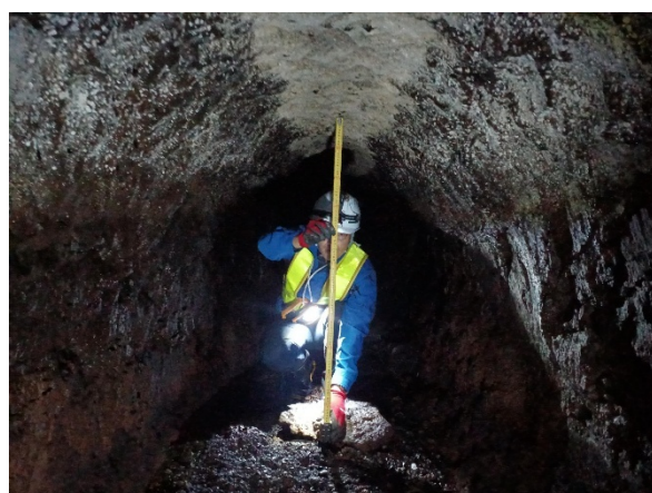
写真 3-4 隧道内の測量調査状況③
