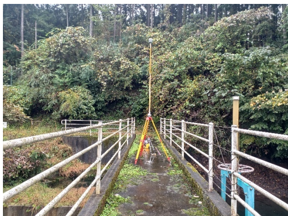
写真 3-1 基準点測量調査状況
