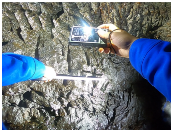
写真 3-6 隧道内の痕跡調査
