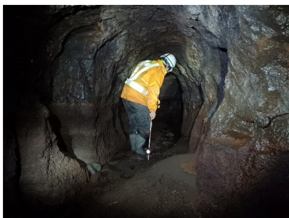
写真 3-3 隧道内の測量調査状況②
