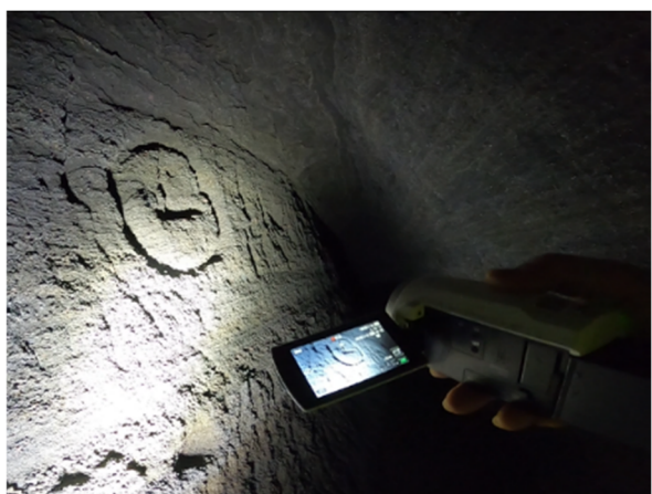
写真 3-7 隧道内の動画撮影
