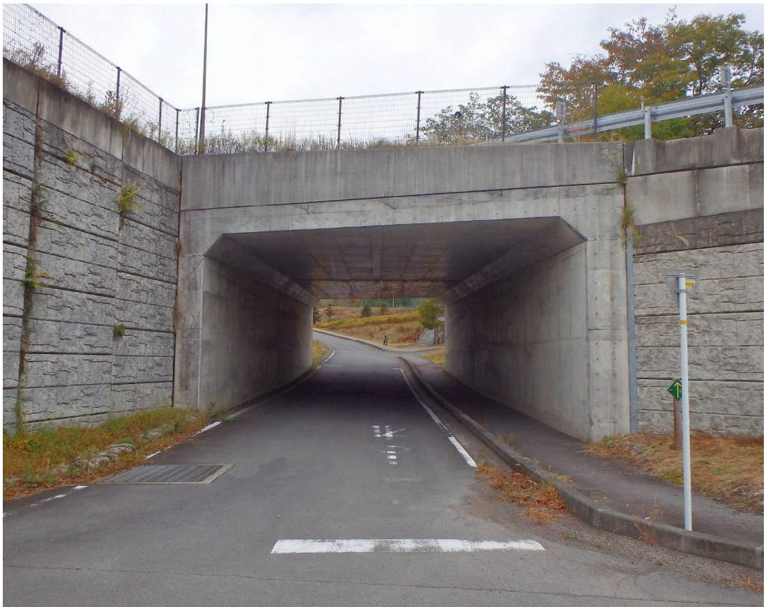
町道 4153 号線 須走カルバート
