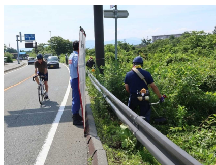
国道138号沿いの草刈り作業
