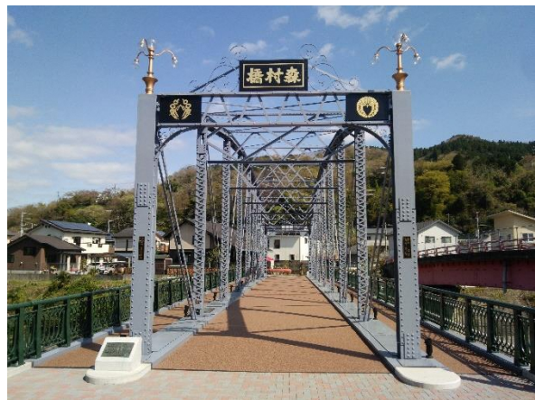
図6-11 復原後の森村橋
