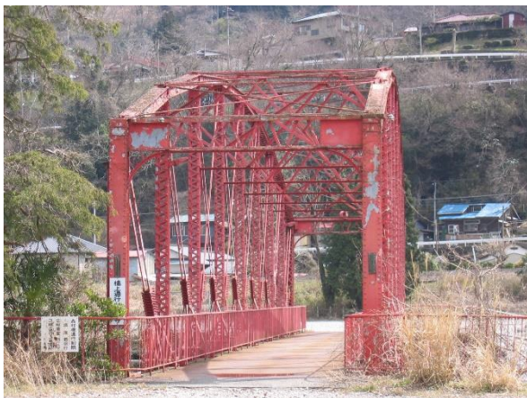
図6-10 復原前の森村橋
