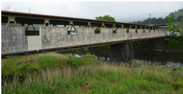
図6-8 工場と社員寮をつなぐ鮎沢橋
