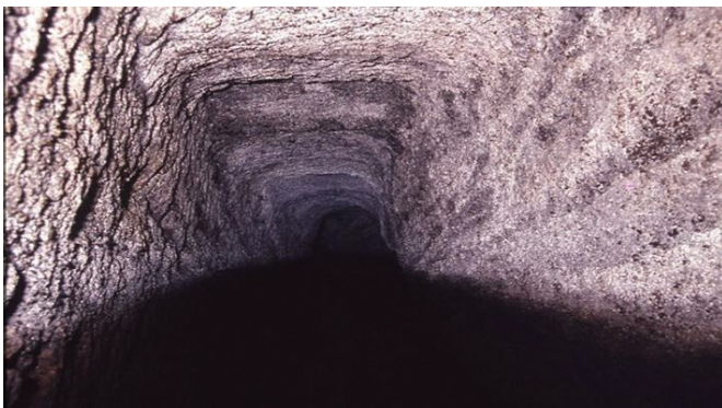
図4-3 あだのようすい すいどうない 阿多野用水の隧道内
