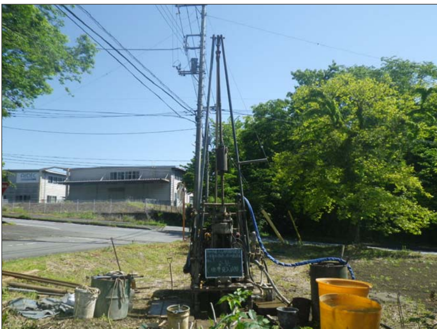
写真区分:No. 1 工種:全景 写真タイトル:全景(標準貫入試験)
