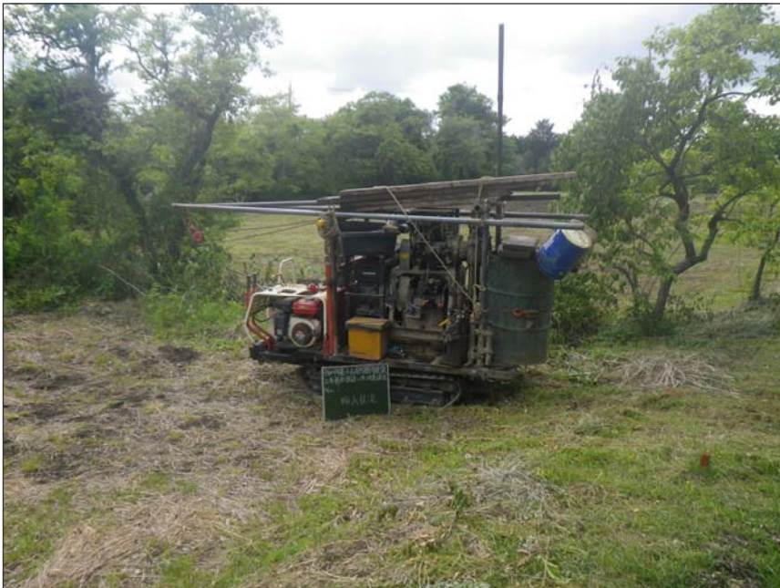
写真区分:No. 1 工種:搬入状況 写真タイトル:搬入状況
