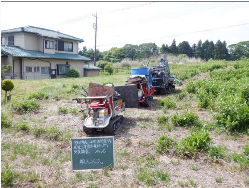
写真区分: No. 2 工種: 搬入状況 写真タイトル: 搬入状況
