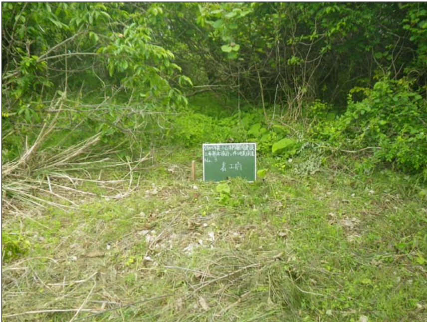
写真区分:No. 3 工種:着工前 写真タイトル:着工前
