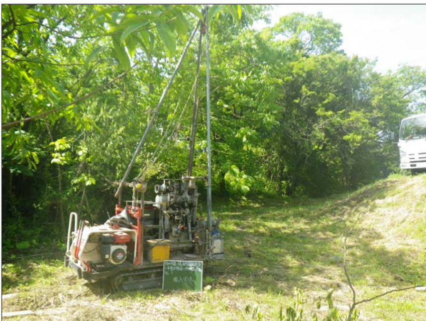
写真区分:No. 3 工種:搬入状況 写真タイトル:搬入状況
