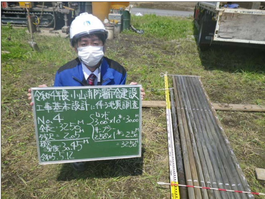
写真区分: No. 4 工種: 検尺 写真タイトル: 検尺(近景)
