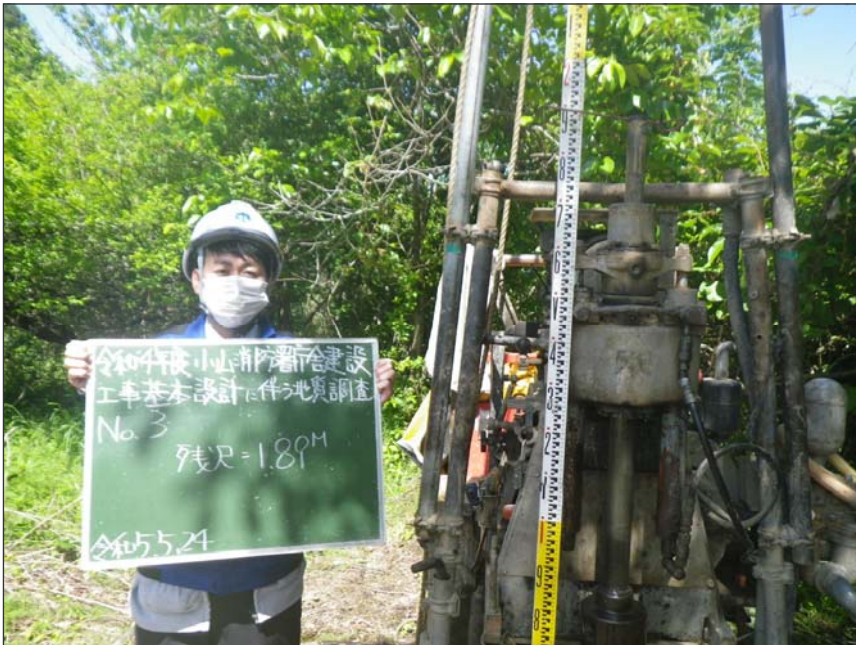
写真区分: No. 3 工種: 検尺 写真タイトル: 検尺(近景)
