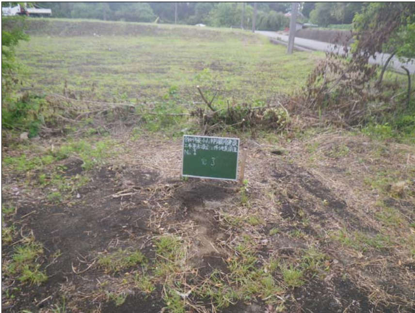
写真区分: No. 1 工種: 完了 写真タイトル: 完了
