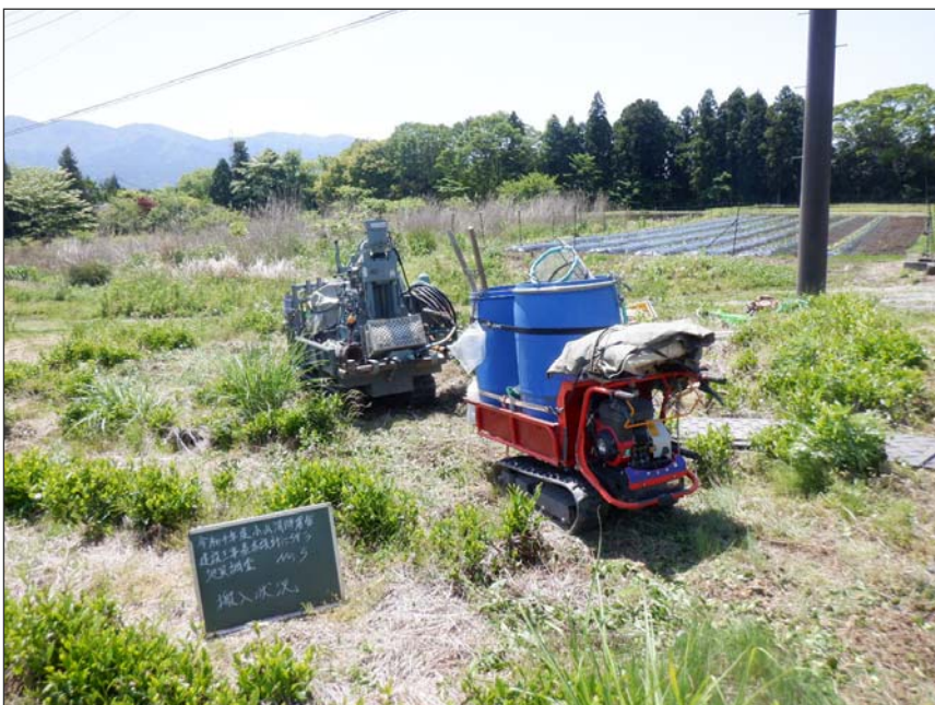
写真区分:No. 5 工種:搬入状況 写真タイトル:搬入状況
