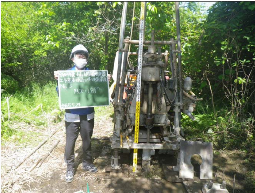
写真区分: No. 3 工種: 検尺 写真タイトル: 検尺(遠景)
