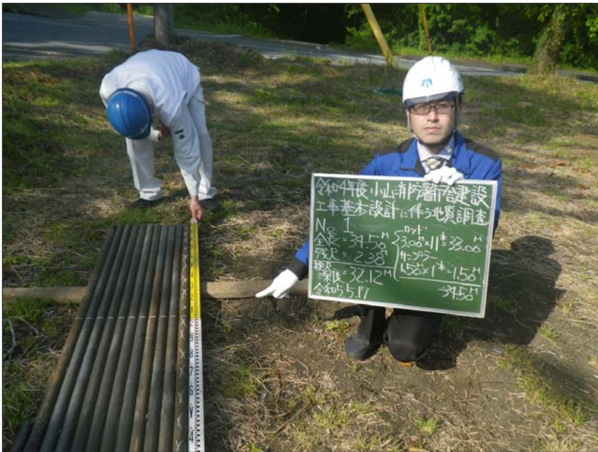
写真区分: No. 1 工種: 検尺 写真タイトル: 検尺(近景)
