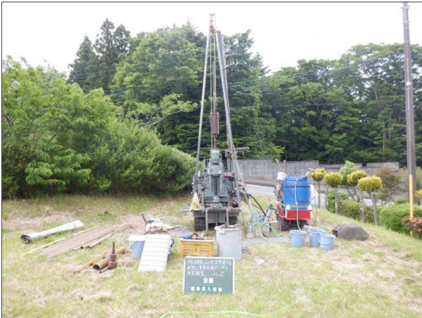
写真区分: No. 2 工種: 全観 写真タイトル: 全観(標準貫入試験)
