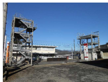
敷地狭隘のため、有効な訓練が実施できない
