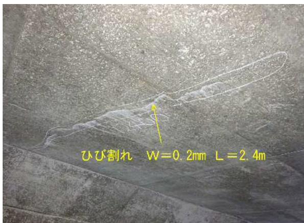
(2) 側壁コンクリートの損傷：ひび割れ
