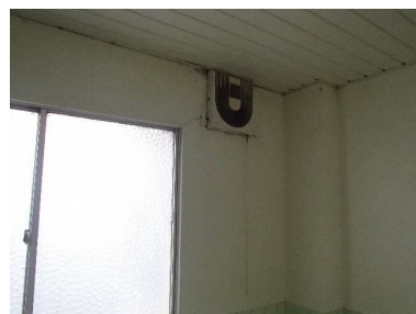
ひび割れが生じている壁
