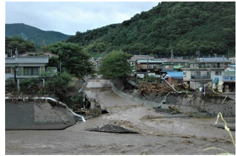
図1-8 平成22年台風9号による被害（野沢川河口）
