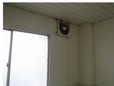
ひび割れが生じている壁
