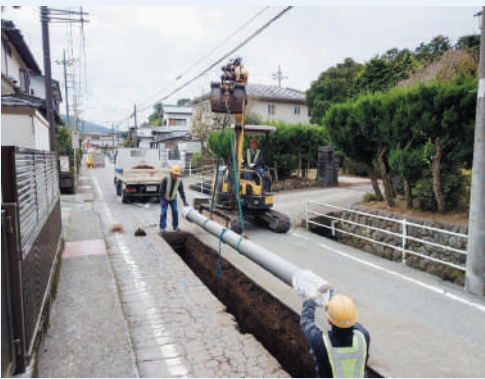
▲藤曲区で実施した更新工事の様子
