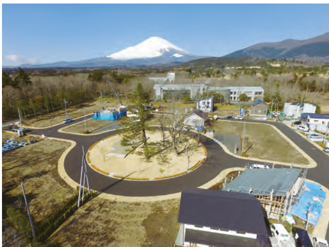
▲全区画が売約済みとなり、住宅建設が進むわさび平分譲地
