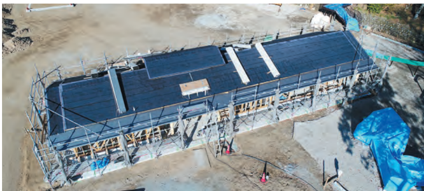
▲建設中の「多世代交流施設」。すてきな愛称をつけて！
