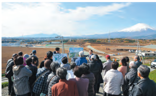
▲湯船原地区の造成現場を見学
