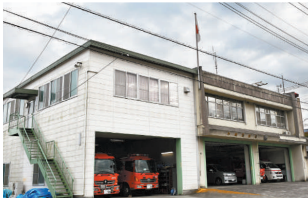
▲老朽化の進む現庁舎
