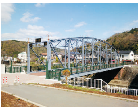
▲ 復原が完了した森村橋
