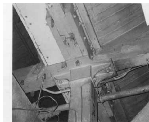
鑄鉄製の接合金物
