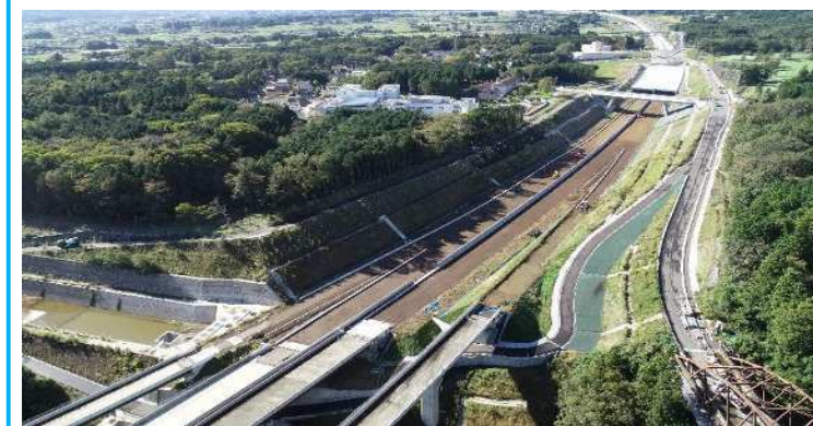
① 須川~用沢跨道橋周辺
