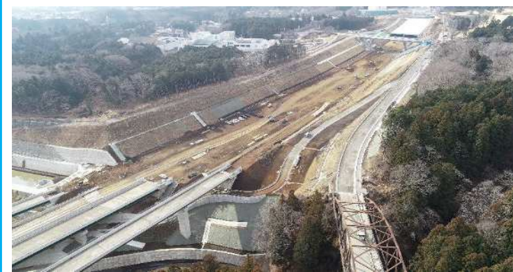
① 須川～用沢跨道橋周辺
