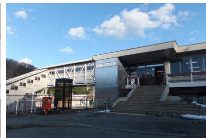
図 3-22 JR 駿河小山駅の駅前広場
