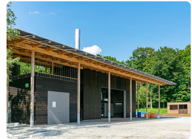
木質バイオマス*利用 （森の金太郎発電所）
