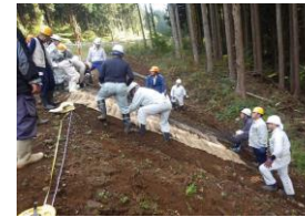
養生マット設置状況
