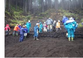
土留工(テラセル)設置状況
