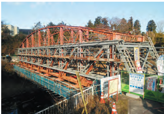
▲仮設橋が組み立てられた状況の森村橋
