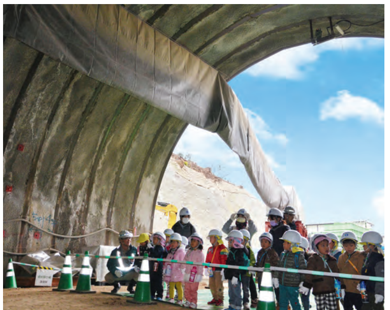
▲トンネル工事現場を見学するいきど保育園の園児たち
