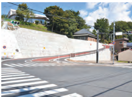
道路整備 ⇒ 町道改良や用地買収、新東名高速道路関連事業とそれに伴う町道整備などを実施
