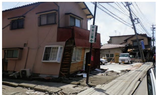
▲熊本地震による家屋の被害状況(防災課撮影 平成28年4月)
