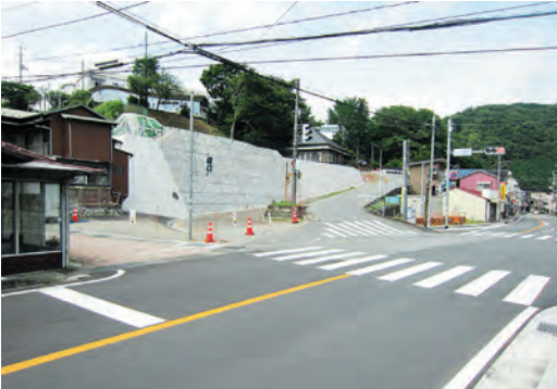
道路整備 ⇒町道改良や用地買収、新東名高速道路関連事業、都市計画道路計画変更決定などを実施
