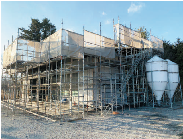
▲応急復旧後の森の金太郎発電所（1月20日撮影）
