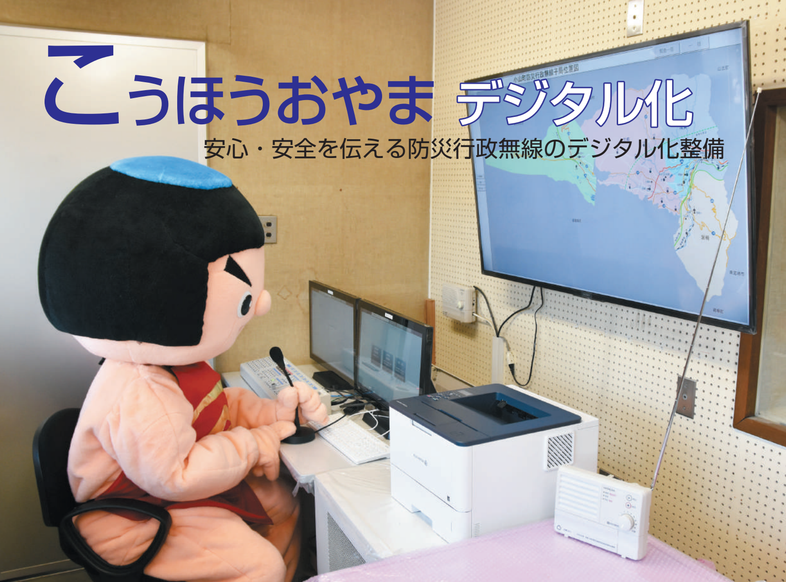
▲役場本庁放送室に設置されたデジタル方式の無線放送操作卓
