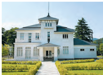
公園・緑地整備の推進 ⇒豊門公園内の西洋館改修工事を実施し、文化財としての価値を高めました
