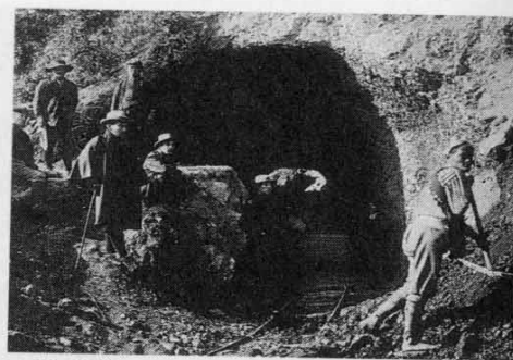
水路開削工事
