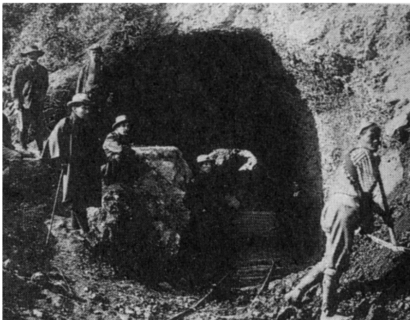
水路開削工事
