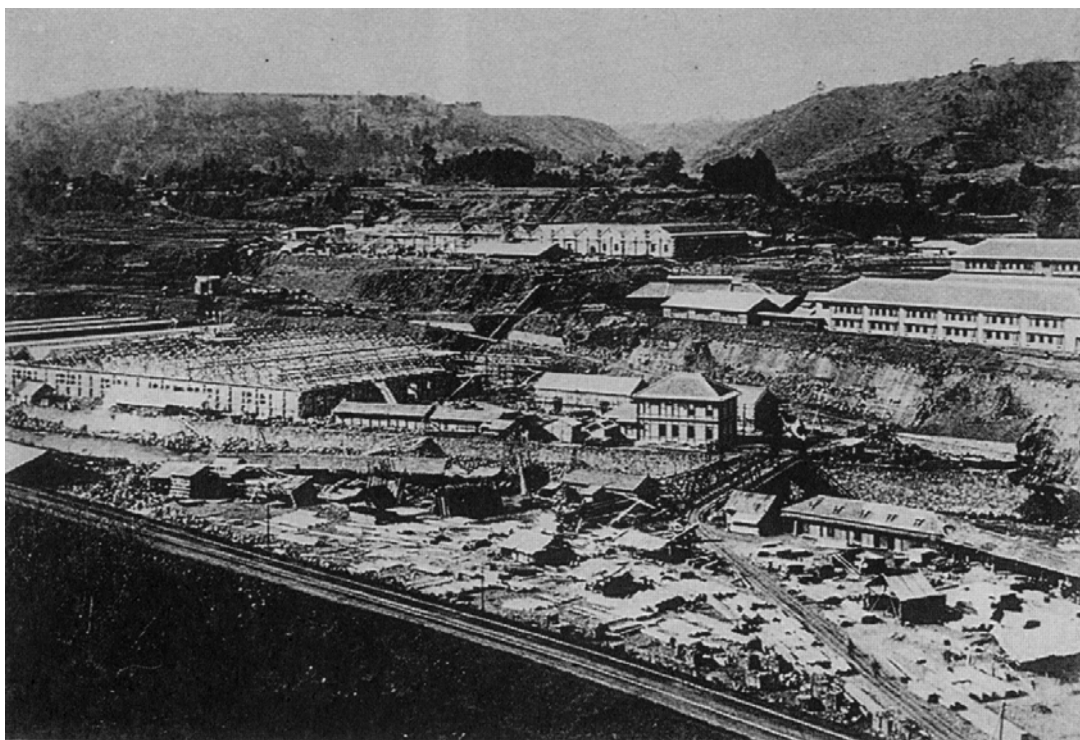
竣工直後の工場建物
