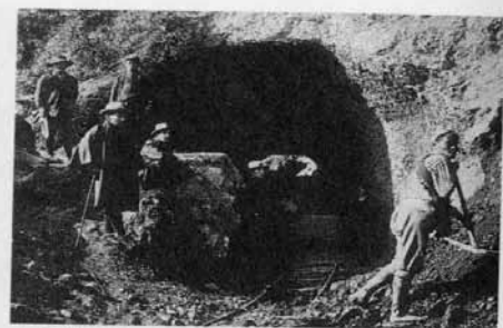
水路開削工事
