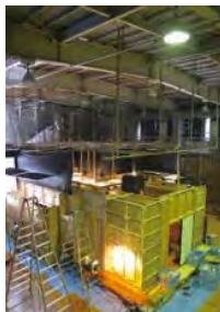
小山フィルムファクトリー 体育館(スタジオ)
