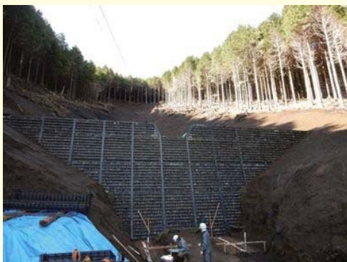
谷止工の施工状況(静岡県小山町)
