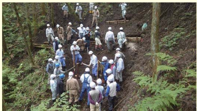
地域住民による木柵工の施工
