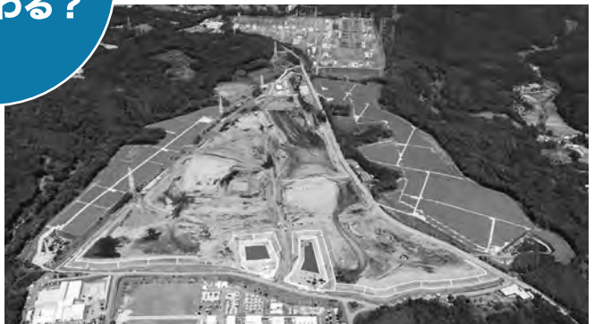
新年度は上野工業団地の造成工事に着手
