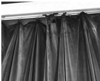
劣化が目立つ菜の花ホールの幕を修繕
