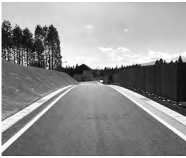
付替え整備した町道4096号線(下原)
