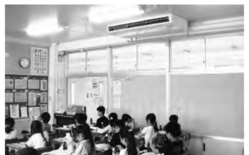
各教室にエアコンを整備(写真は設置例)
