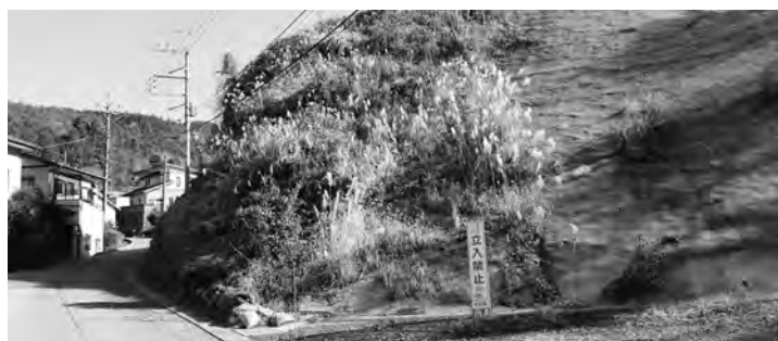
神田急傾斜地工事の完成は次年度へ(向方)
