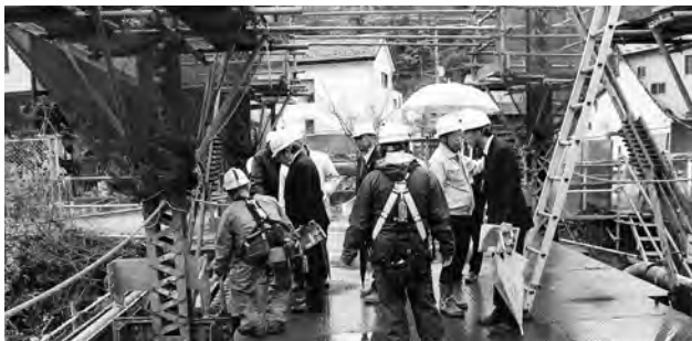
森村橋復原工事の進捗状況の説明を受ける
