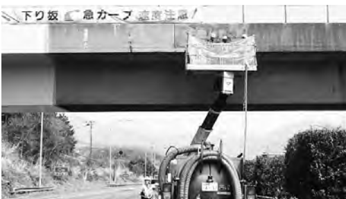
補修作業中の東名道路橋（古城橋）
