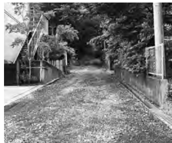
舗装整備する町道4199号線（須走）
