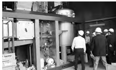
建設中のバイオマス発電所を視察
