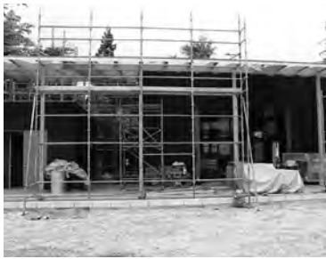
建設中の木質バイオマス発電所（上野）
