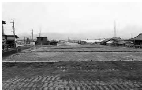
都市計画道路・大胡田用沢線の延伸箇所
