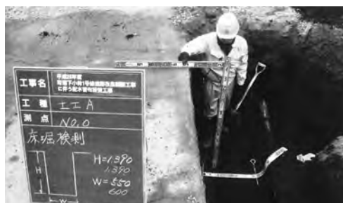
老朽化した水道管を計画的に布設替
