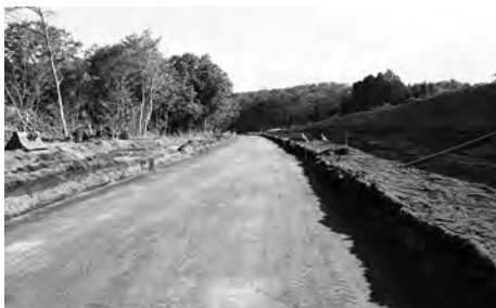
工事中の南北幹線道路(町道3078号線)
