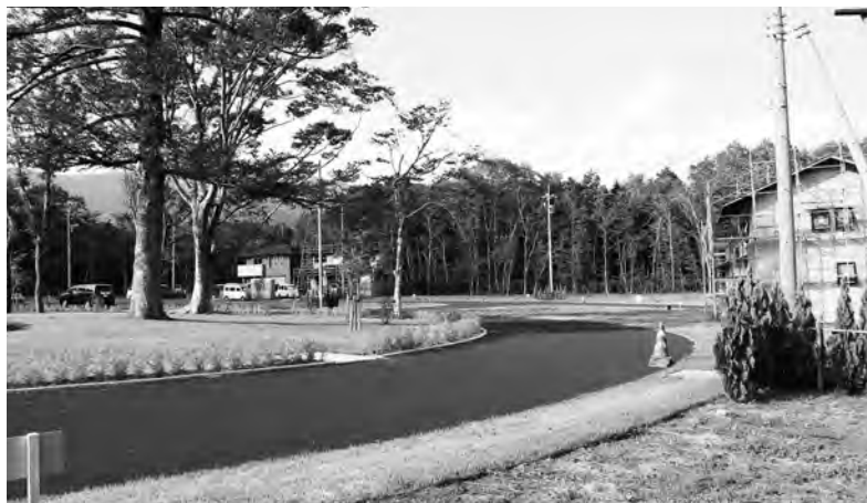
優良田園住宅は全36区画を分譲 販売済の区画で建築が始まる (用沢・わさび平)
