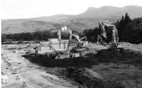
旧RDFセンターの解体工事もほぼ終わる(桑木)
