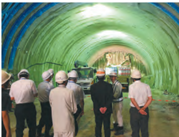
掘削は地質を綿密に計算して進む
