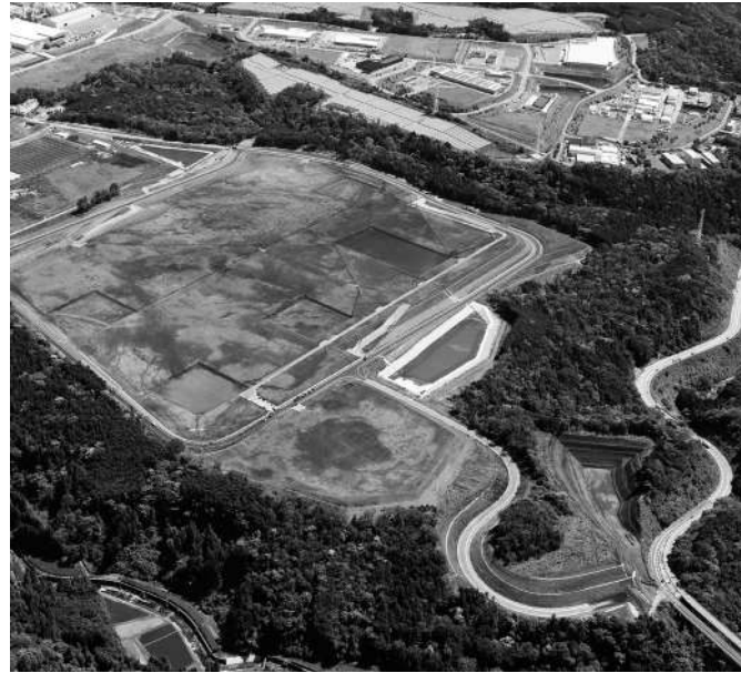
造成が完了した上野工業団地
