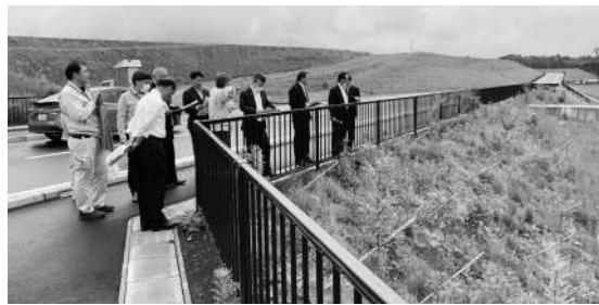
上野工業団地の状況を確認
