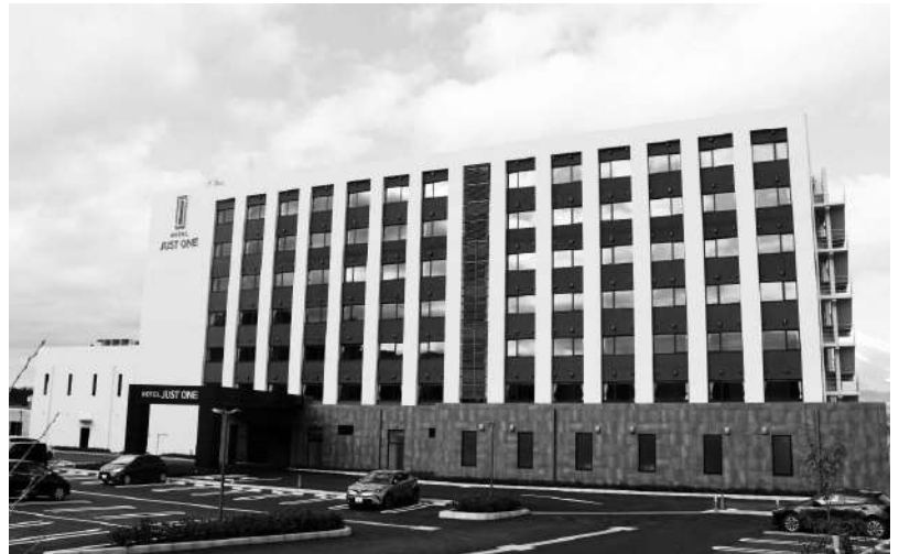
災害時における宿泊施設等の提供に関する協定を結んでいる宿泊施設
