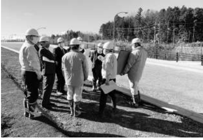
町道2415号線の進捗状況を確認
