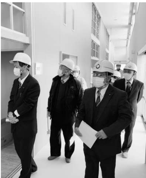
建設中のすばしりこども園
