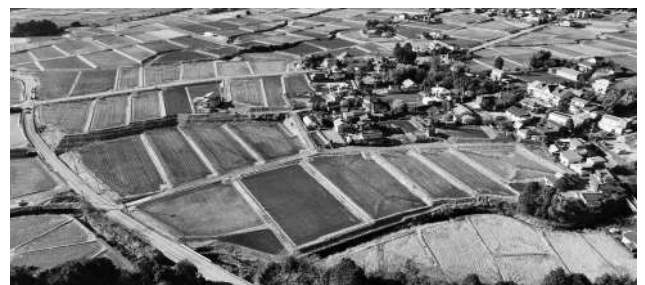
ほ場整備工事が完了した大胡田工区
