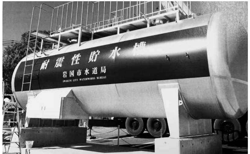
岩国市の飲料水兼用耐震性貯水槽
