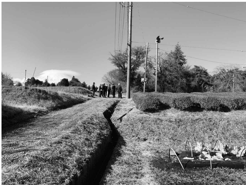
小山消防署建設予定地を確認
