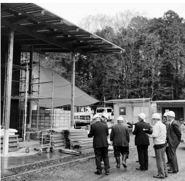
復旧工事中の木質バイオマス発電所を確認
