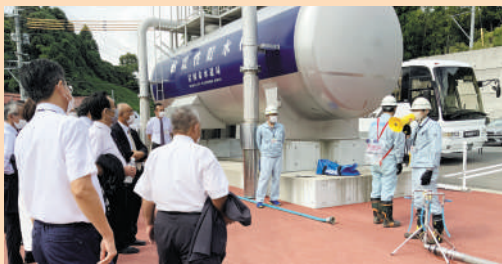
岩国市の耐震性貯水槽
