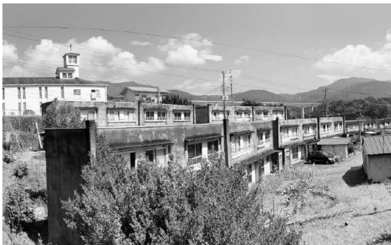
老朽化が進んでいる町営住宅
