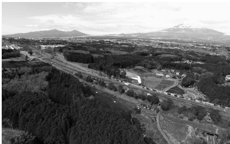
令和5年度中の供用開始に向け、開発道路は現在も工事中
