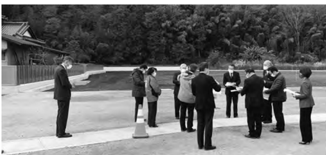
(仮称)すがめまこども園 建設工事現場を確認
