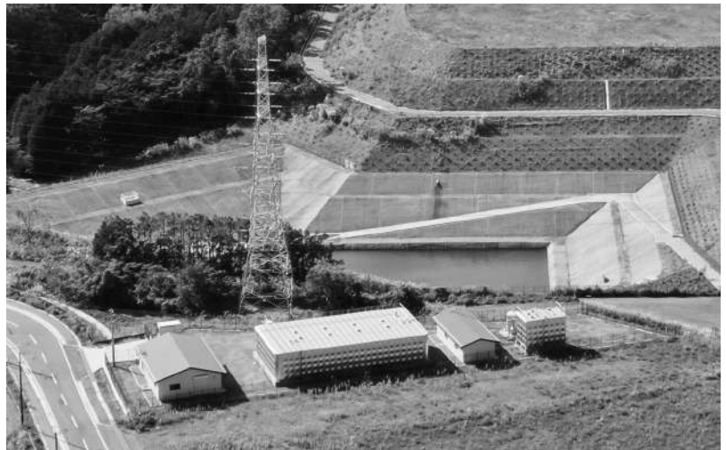
1日最大給水量2500m 3 の湯船原の上水道施設
