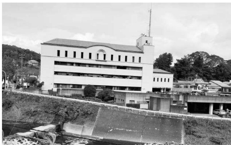
38年経過している役場本庁舎
