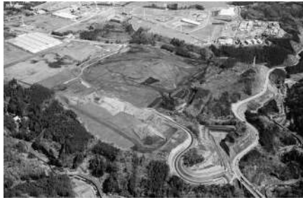
造成工事が進む上野工業団地
